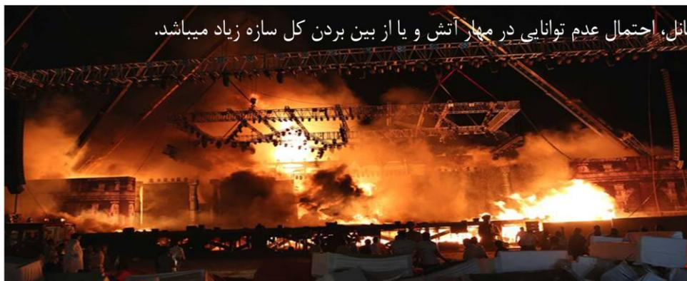
سوزی در این نوع از پانل، احتمال عدم توانایی در مهار آتش و یا از بین بردن کل سازه زیاد میباشد.
